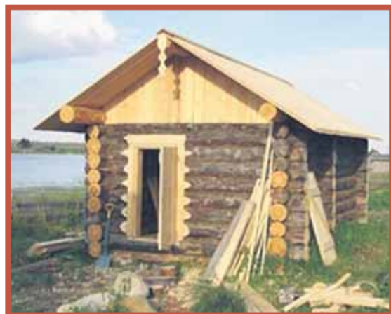
Rakennussampo pystyttää vanhalla perinteellä tehtyjä vienankarjalaisia savusaunoja jonka hirsikehikko, karmit ja ovet tehdään Paanajärvellä Vienassa.
